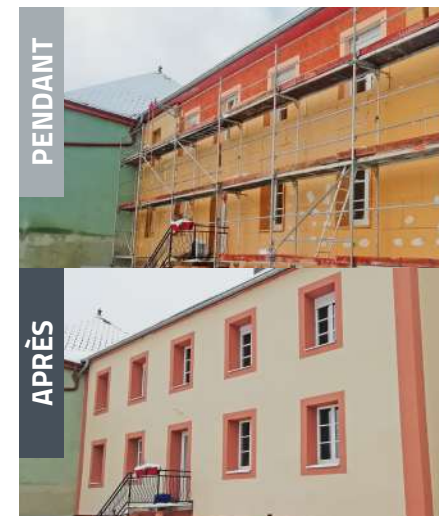
↑ Rénovation d'un bâtiment communal à Trévillers ✓ Installation de panneaux solaires sur la toiture de l'école de Plaimbois-du-Miroir
