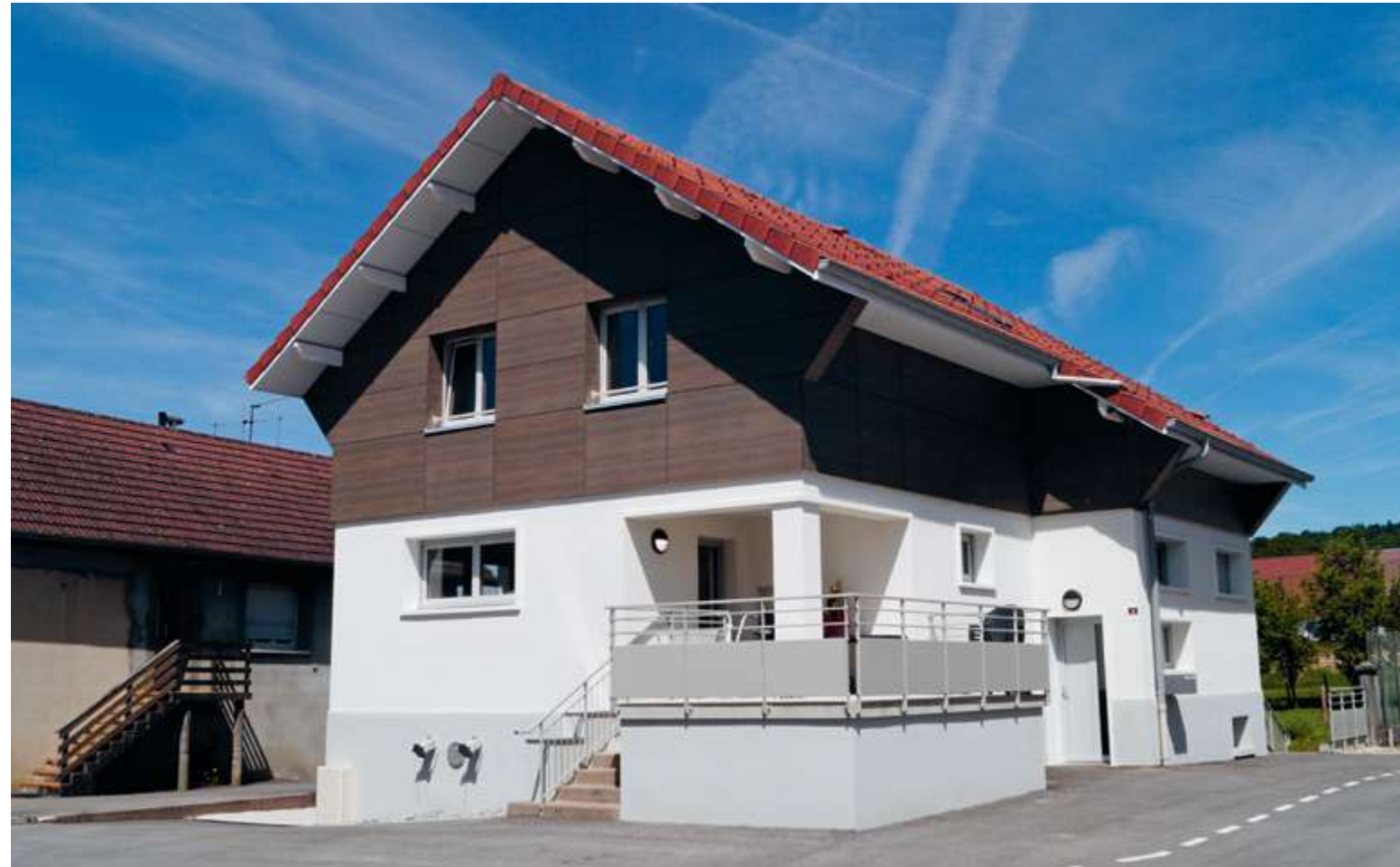
Rénovation du bâtiment de l'ancienne poste à Landresse – Création de 2 logements et mise en place d'une chaufferie bois avec réseau de chaleur au sous-sol
