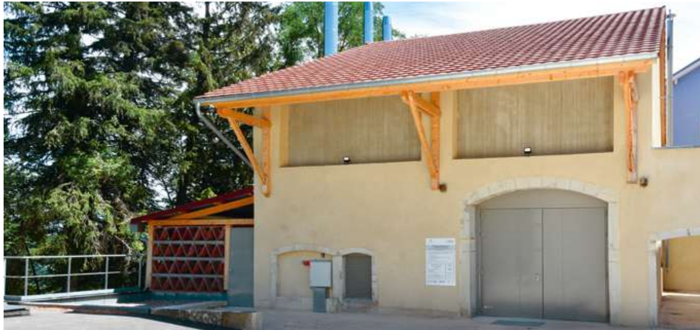
La chaufferie de Blamont et son réseau de chaleur, mise en service en octobre 2025
