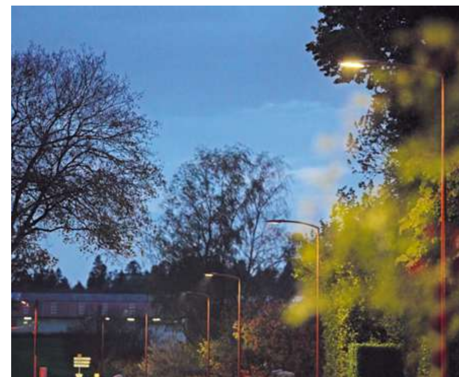
Rénovation du parc d'éclairage public à Méréy-sous-Montrond
