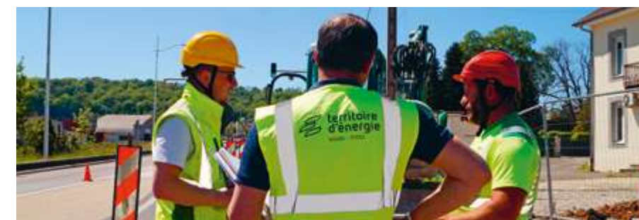
Chantier d'enfouissement à Chalezeule
